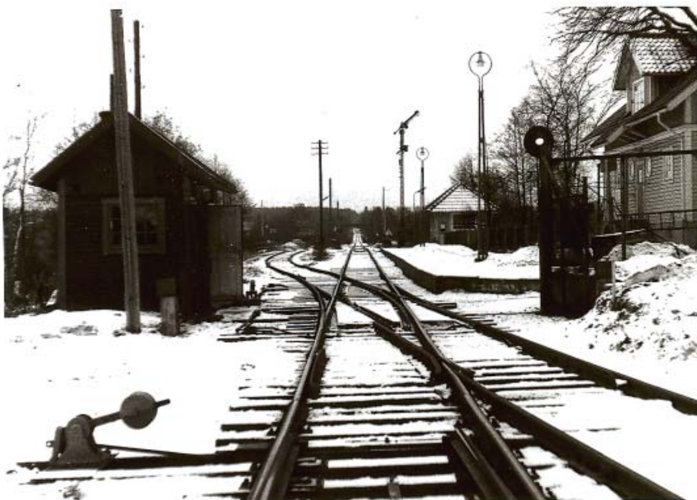
Banvaktstugan vid Jordbron. Här börjar Slakthusspåret, det som viker av åt vänster. Foto: Bengt Spade. Bilden är tagen från Munksjö industriområde.
